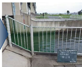
対策後の状況
