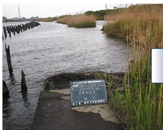
点検時の状況
