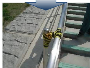
対策後の状況
