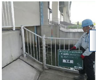
点検時の状況
