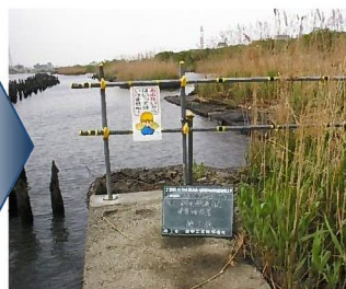
対策後の状況
