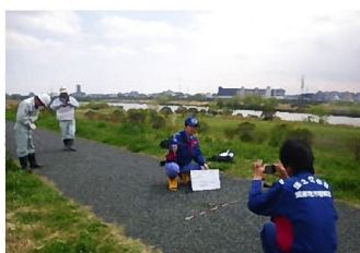
堤防天端道路の破損状況
