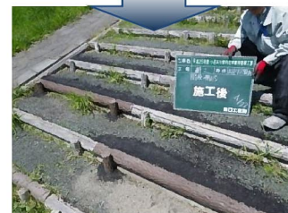
対策後の状況
