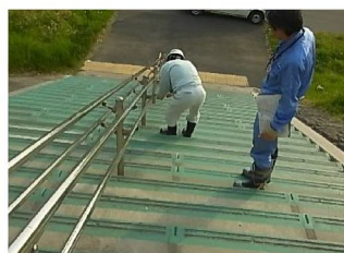
堤防階段手すりの変形補修
