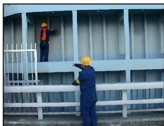
水門の保守・点検
