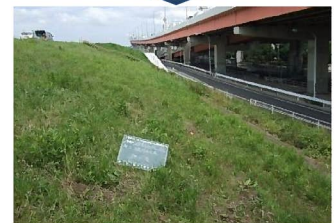
対策後の状況
