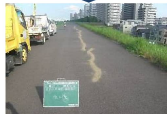
対策後の状況
