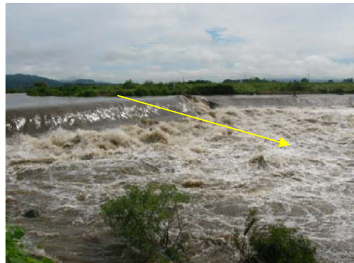
小貝川右岸65.9km付近(井出姥沢堰) 筑西市八田地先 下流から上流を望む
