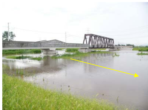
小貝川右岸60.6km付近 筑西市成田地先 天端より上流のJR橋梁を望む
