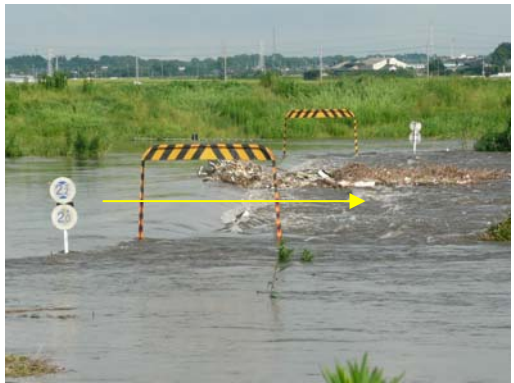
小貝川右岸20.7km付近(川又橋) 常総市川又地先 天端から川又橋を望む
