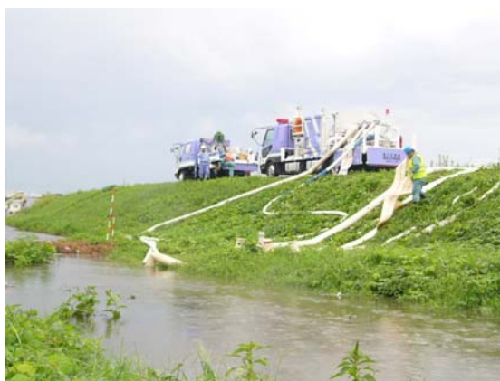
排水ポンプ車による内水はん濫箇所から小貝川へ排水
