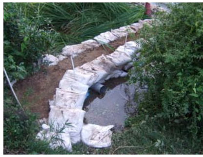
漏水箇所対策状況(小貝川右岸52.8k付近)
