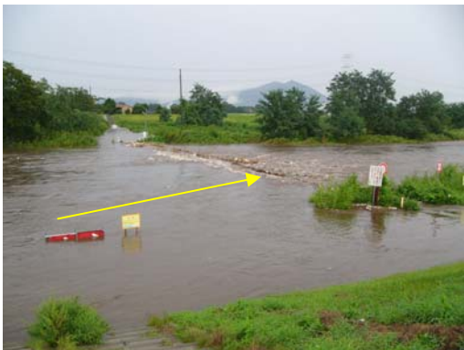
小貝川右岸59.5km付近(深見橋) 筑西市島地先 上流から下流を望む
