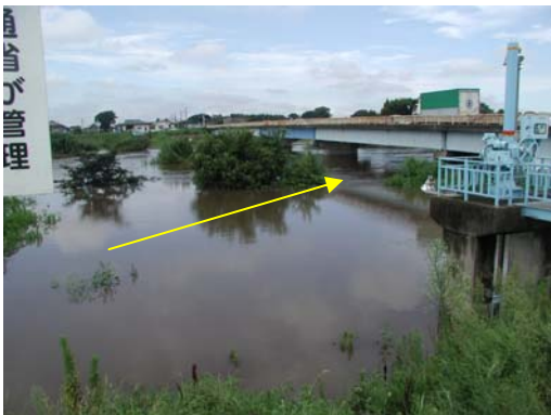
小貝川左岸40.4km付近(愛国橋)つくば市吉沼地先 天端(国神排水樋管)から愛国橋を望む
