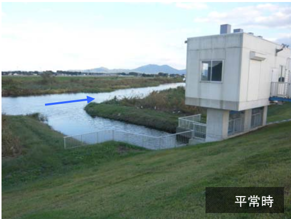
小貝川右岸68k付近八田上排水樋管
