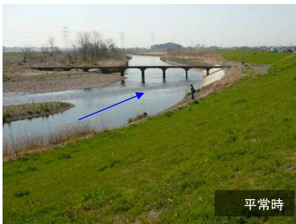
小貝川59.5k付近深見橋
