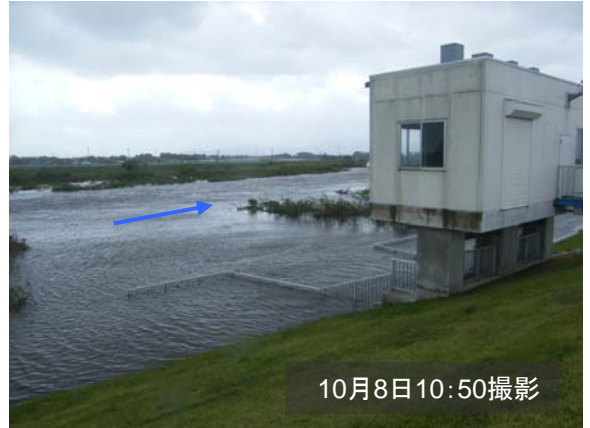
小貝川右岸68k八田上排水樋管
