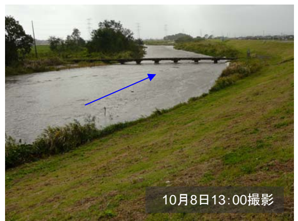
小貝川59.5k付近深見橋
