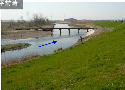
小貝川59.5k付近深見橋
