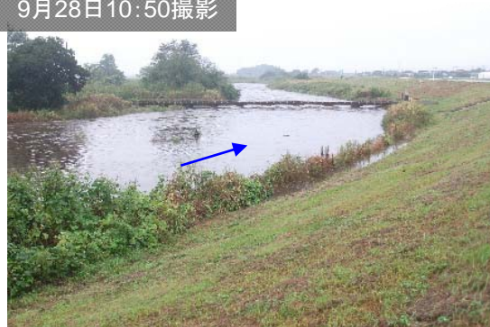
小貝川59.5k付近深見橋
