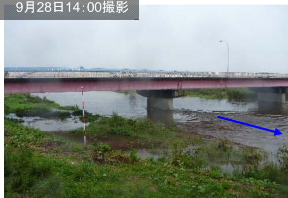
黒子橋 小貝川右岸53.5k付近
