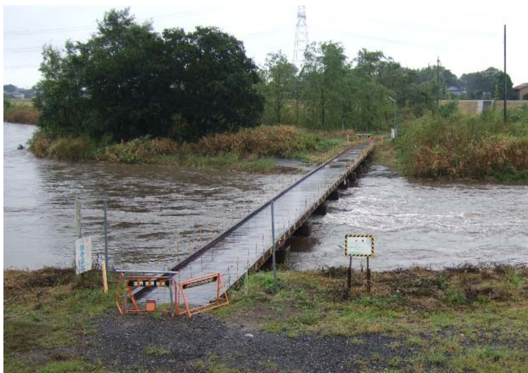
小貝川 筑西市 深見橋
