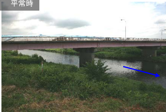
黒子橋 小貝川右岸53.5k付近
