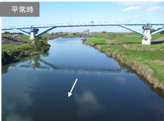
黒子橋から上流側を撮影(筑西市)
