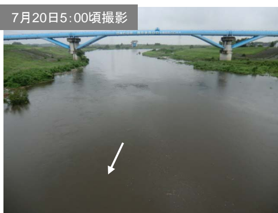
黒子橋から上流側を撮影(筑西市)
