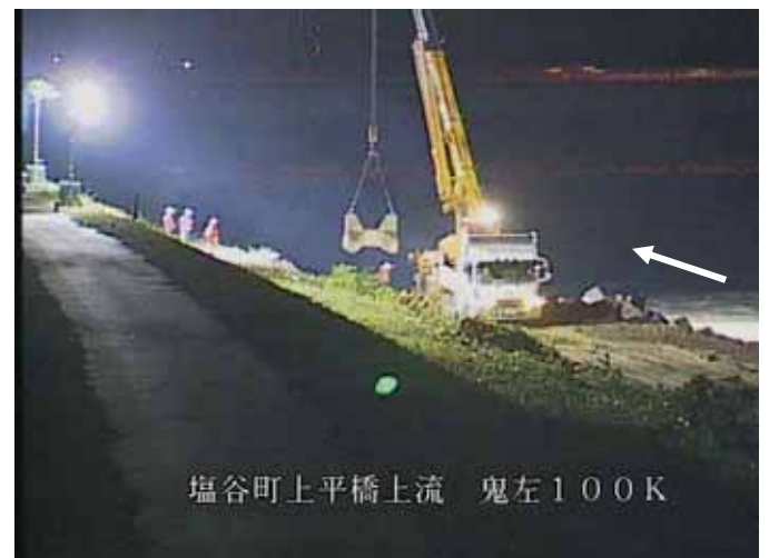
復旧状況(23日23時頃)
