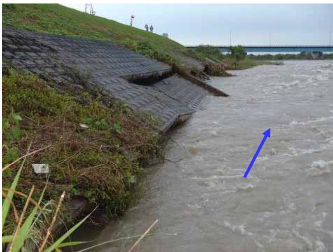
被災状況(22日17時頃)
