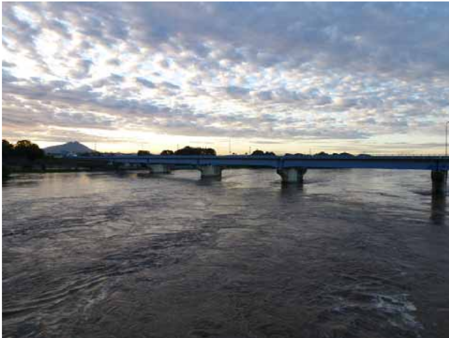
鬼怒川 川島橋(旧国道50号)から下流を撮影 22日5:30頃 左岸筑西市・右岸結城市
