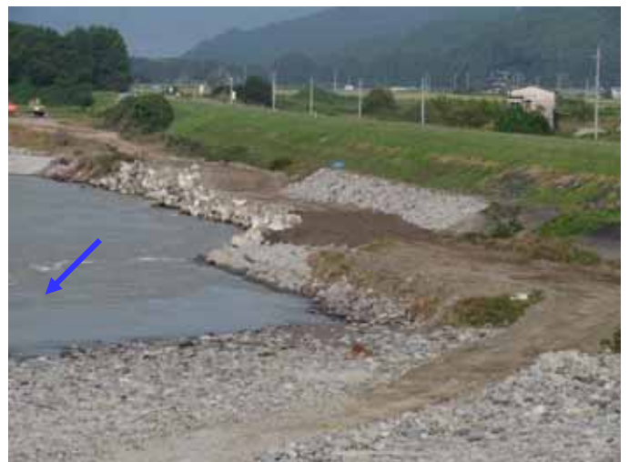
復旧状況(26日8時頃)
