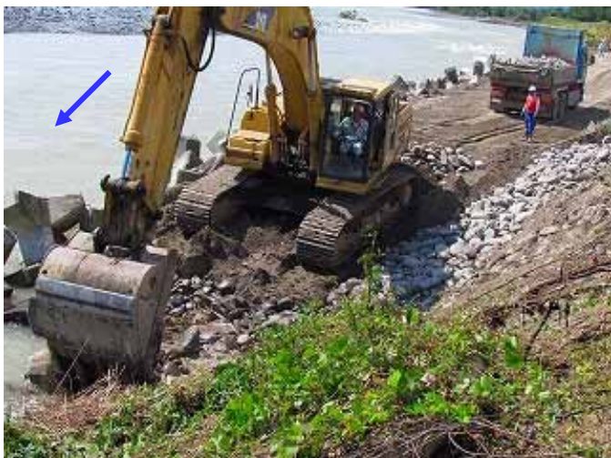
復旧状況(24日12時頃)
