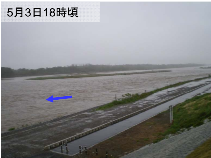
鬼怒川 左岸55k付近 旧大道泉橋付近
