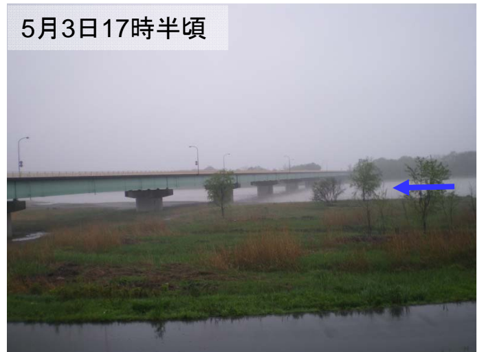
鬼怒川 左岸56.5k付近 砂ヶ原橋 11
