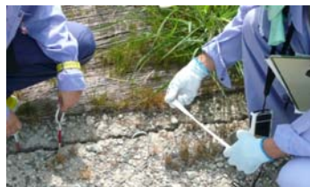
ひび割れの確認
