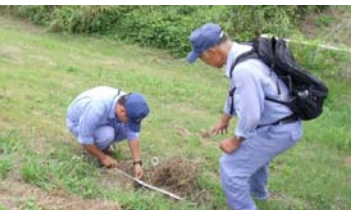
堤防の穴を確認
