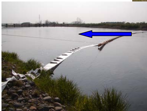
オイルフェンス設置状況
