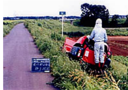
鬼怒川堤防の除草状況
