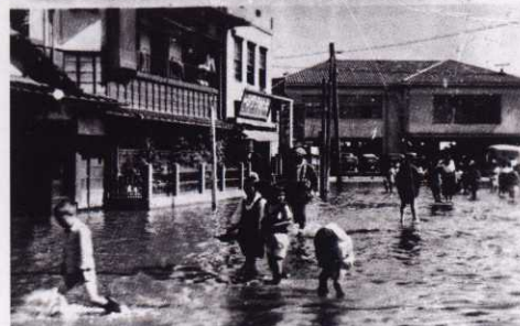
▲筑西市下館駅前
