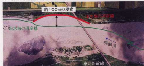
▲平成13年9月の洪水。出水により川岸が削られた東北新幹線橋梁付近
