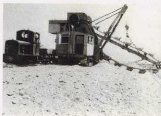
▲ラダーエスカベータによる築堤工事 (昭和10年頃、宇都宮市石井付近)
