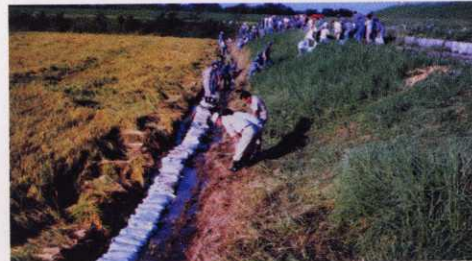
▲昭和57年9月の洪水による漏水状況。常総市樋ノ口地先
