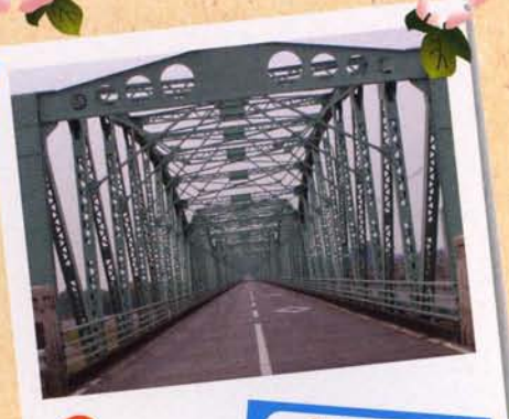
旧鬼怒橋 75.4km 15連のプラットラス橋 1931年建造
