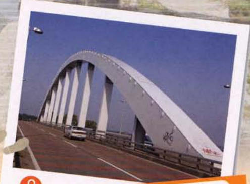
祝橋 45.8km 2000年建造の国道125号に 架かるアーチ橋
