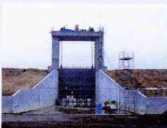
工事中の田谷川水門
