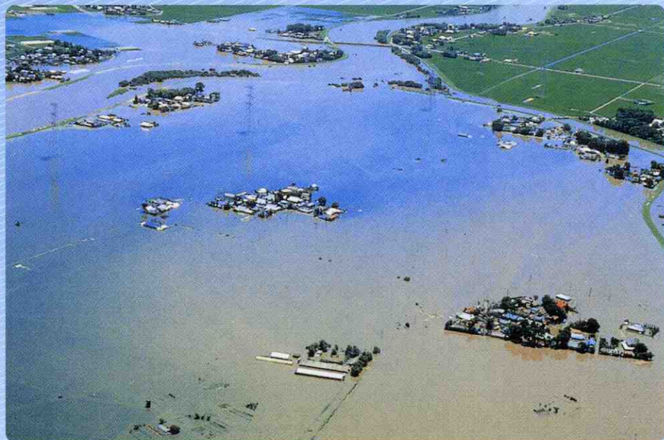
洪水被害の大きかった小貝川、大谷川合流点付近
