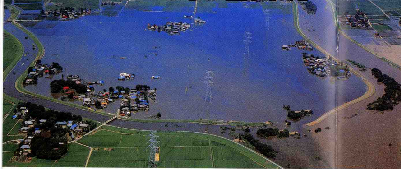
空から見た昭和61年8月の洪水による被害の様子
