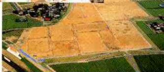
盛土が完成した移転地
