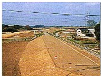
強化された堤防(協和町の小栗築堤工事)
