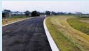
茨城県下館市奥田地先 小貝川右岸大開橋下流の 築堤状況
