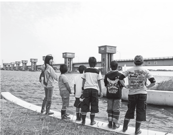
多自然魚道から利根川河口堰をのぞむ
