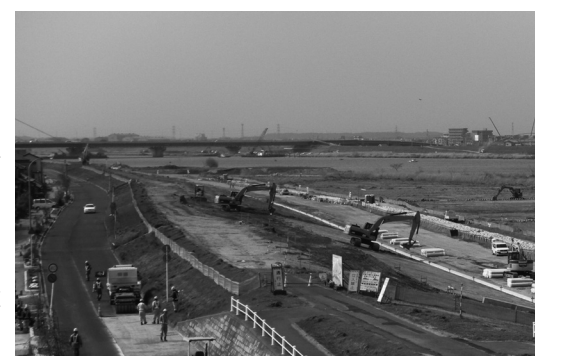
千葉県香取市佐原地先の災害復旧状況
