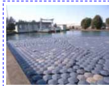
出典：正六角形ポリエチレン製のフロートを使った遮光設備（北総東部用水） 環境報告書2008 独立法人水資源機構
