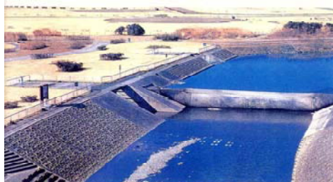
出典：河川直接浄化の手引き 平成9年3月31日 (財)国土開発技術研究センター 野川浄化施設 ラバー堰
