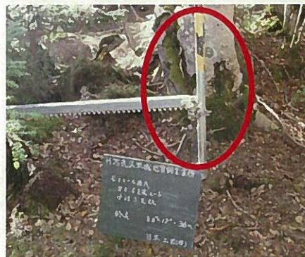
写真 6-1: モノレールの起点 (左)・終点 (右) レール端部に支柱を設置
