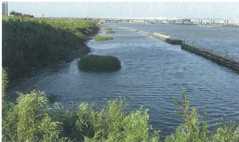
写真 4. 2. 2 消波施設背後の河岸地形の変化 <小松川地先 船堀橋上流工区>
