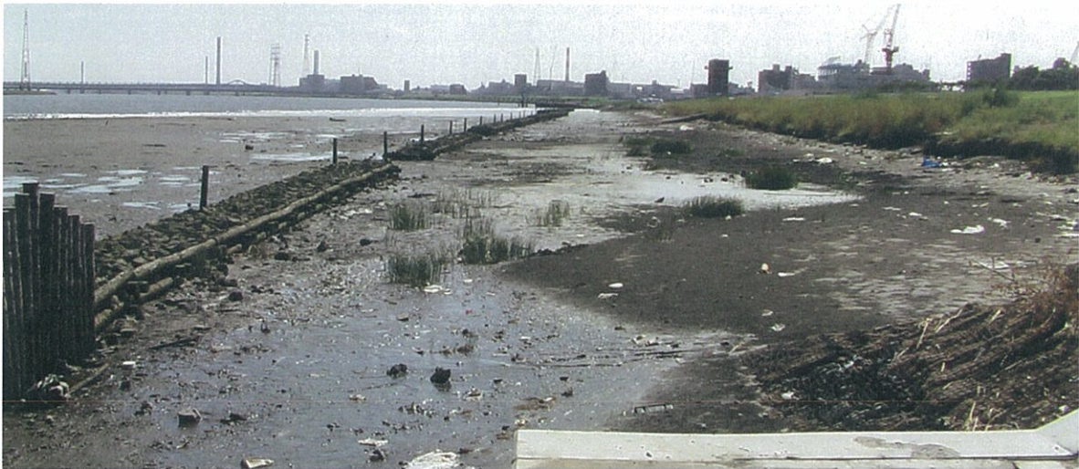
写真 4. 2. 2 消波施設背後の河岸地形の変化 <小松川地先 船堀橋上流工区>
