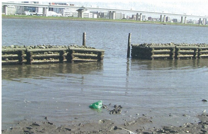
写真 4.2.1 木工沈床工の天端高計測と中詰め材の状況確認
