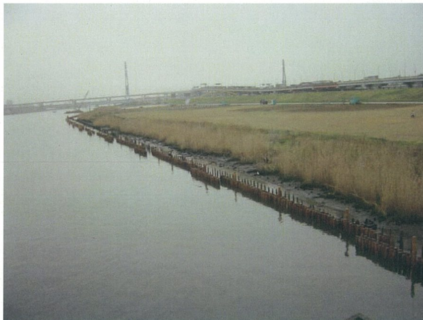
写真 3. 5. 2 四つ木地先の柱列杭
