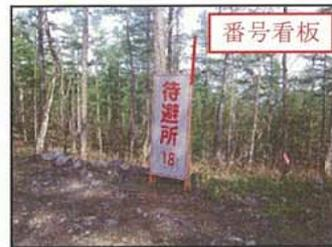
また、番号表示した林道内各待避所の中間地点に標識を設置し、工事車両が出くわした場合にどちらの待避所が近い目安にし、後退で戻る車両の距離が少なくなるようにしました。
