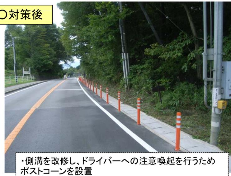
・側溝を改修し、ドライバーへの注意喚起を行うためポストコーンを設置
