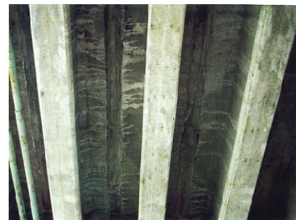
床版の遊離石灰漏出状況
