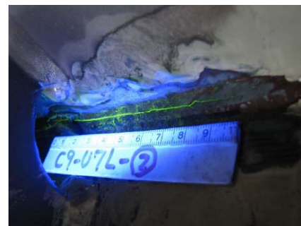
鋼床版の亀裂の状況
