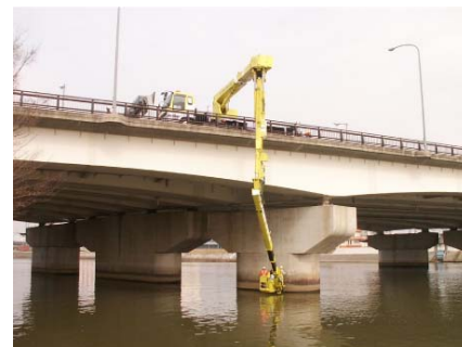
橋梁点検状況（橋梁点検車）
