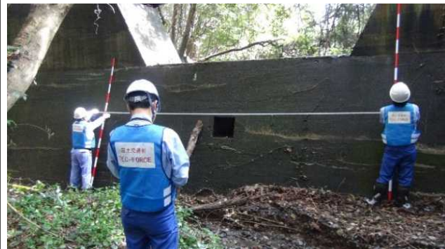
① 砂防施設(堰堤)の点検状況 (調査箇所:五郎川)
