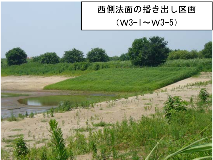
写真. 播き出し後の状況（平成22年7月21日撮影）
