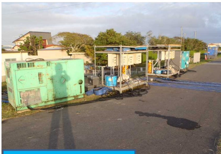
排水ポンプ設置状況(10月25日)
