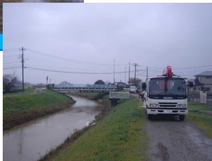
排水ポンプ設置状況(10月25日)
