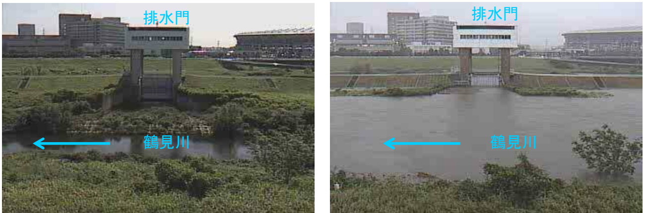
鶴見川多目的遊水地(排水門)
