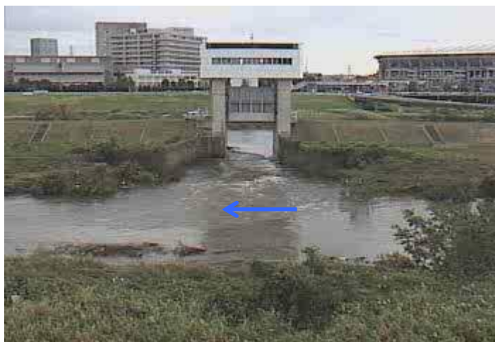
鶴見川多目的遊水地排水門からの排水状況(10月16日13時00分頃)
