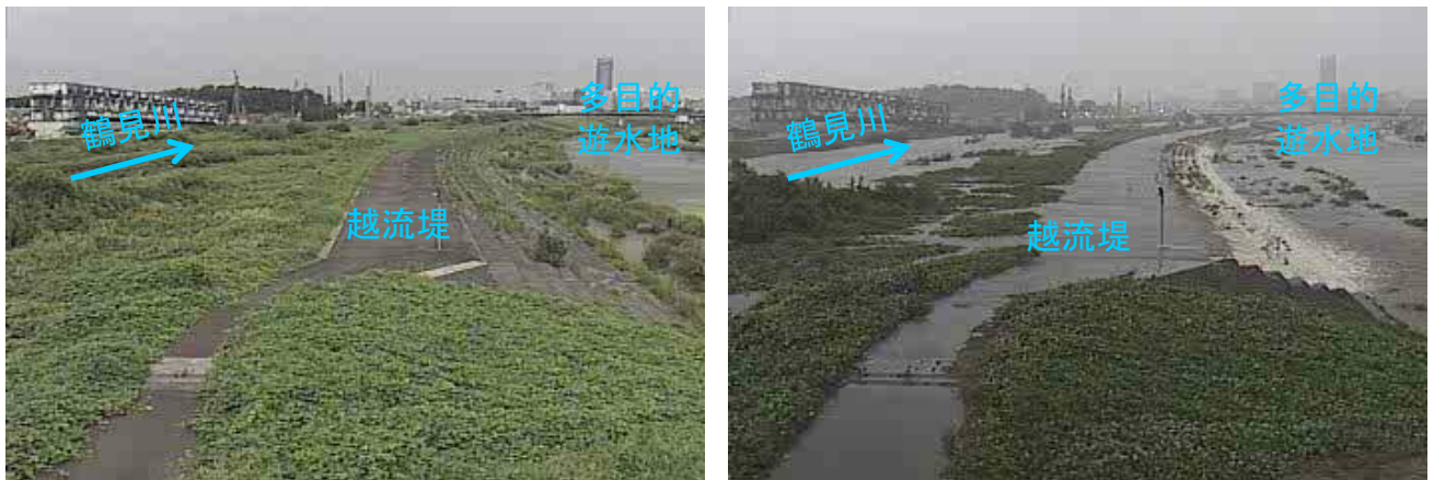
鶴見川多目的遊水地(越流堤)
