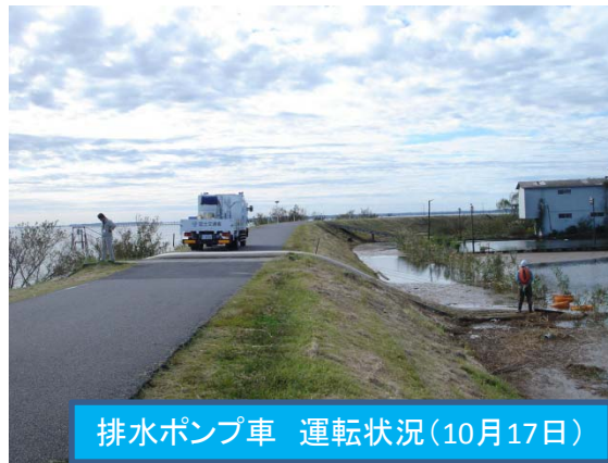
排水ポンプ車 運転状況(10月17日)
