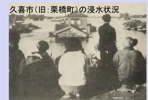
久喜市(旧:栗橋町)の浸水状況
