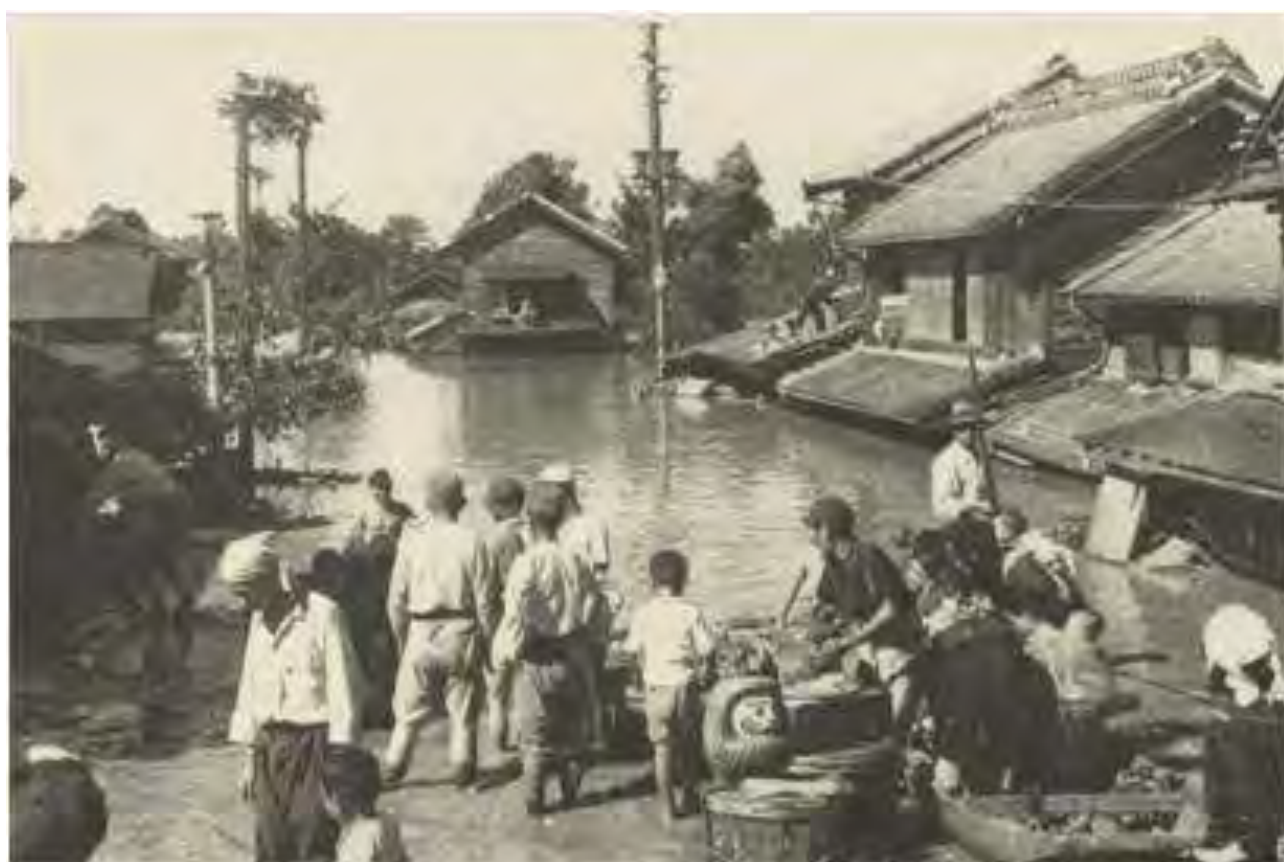
久喜市(旧:栗橋町)の浸水状況
