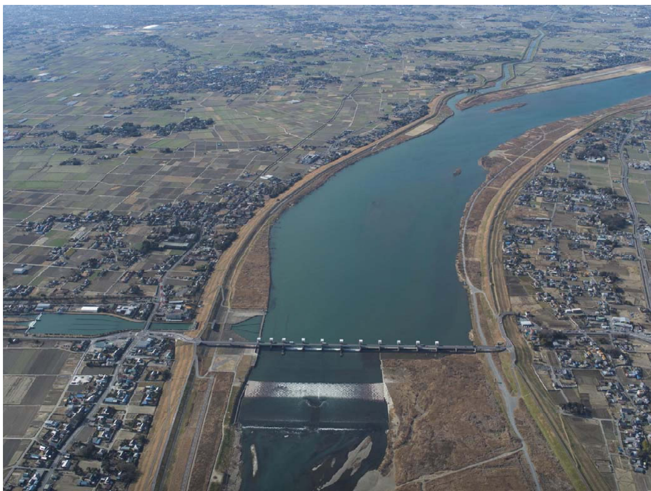
利根大堰付近
