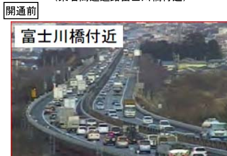
写真3-1 開通区間の混雑解消状況 (東名高速道路富士川橋付近)
