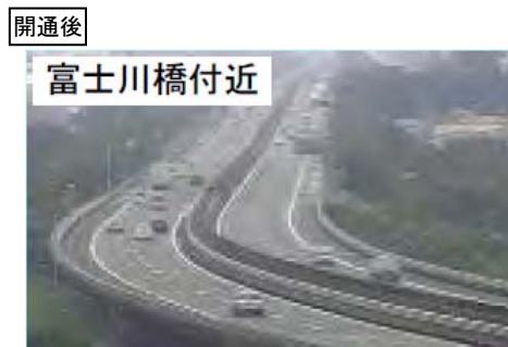
写真提供: 新東名(静岡県)インパクト調整会議
