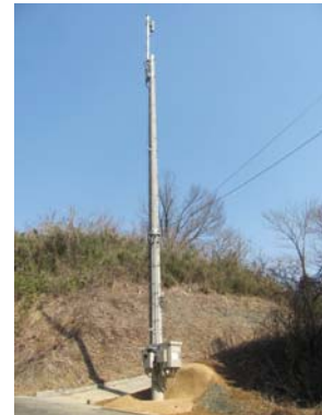
写真4-2 携帯電話基地局整備状況
