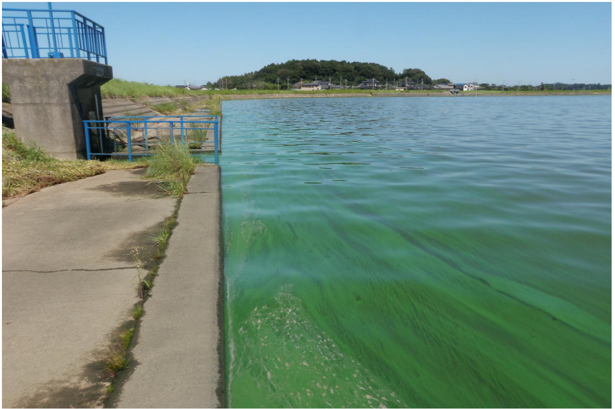
西浦中岸31.75km+100m レベル3~4 悪臭無し
