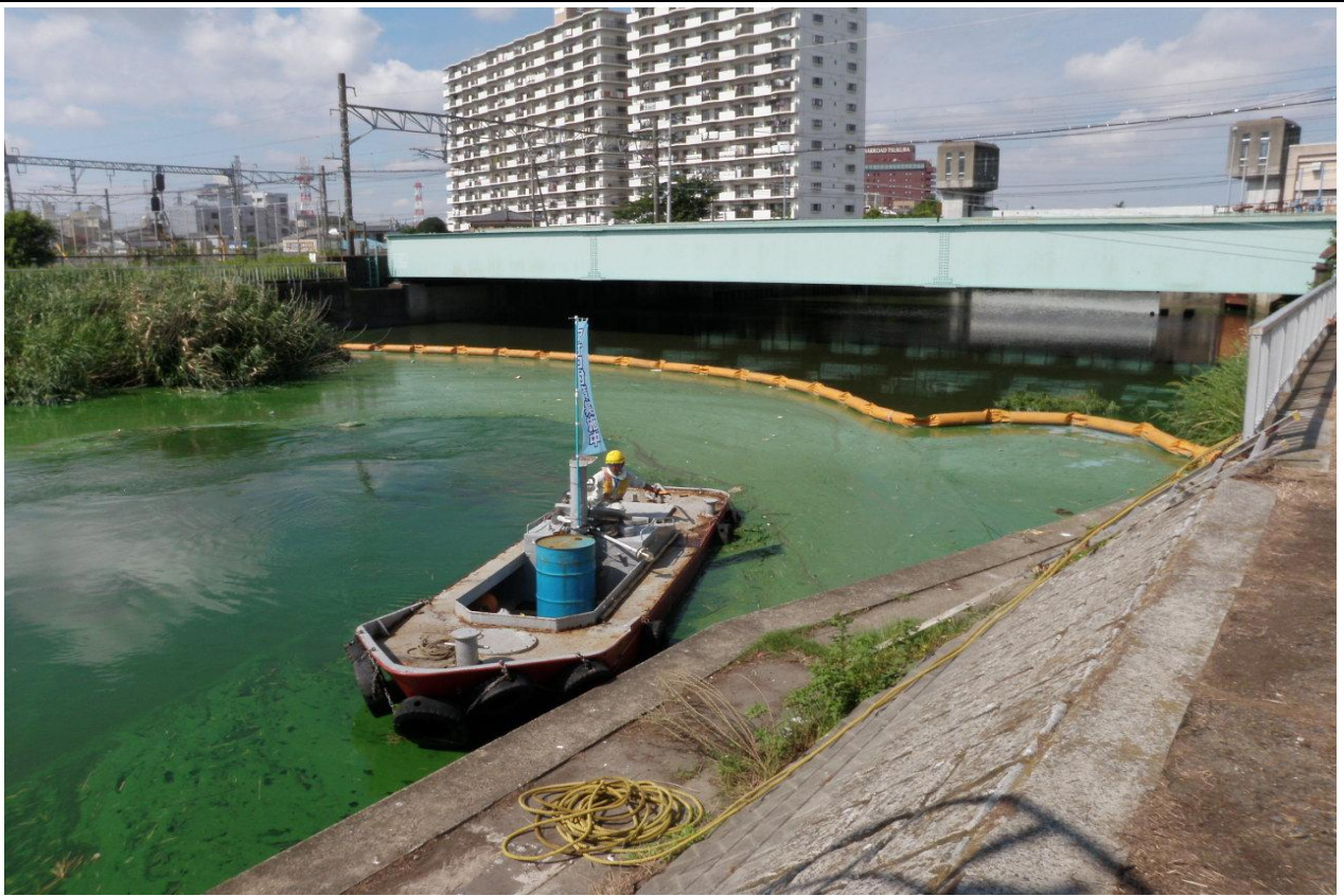
西浦中岸2.75km+40m（新川）レベル4～5 悪臭有り 作業船によるアオコ攪拌・流送作業実施中。
