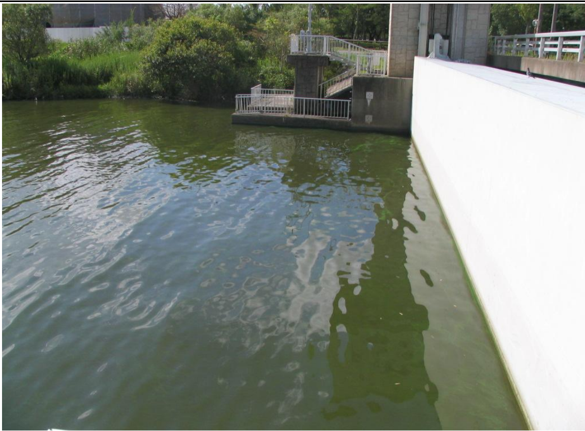
西浦右岸47.25km+50m 備前川河口 レベル3 悪臭無し
