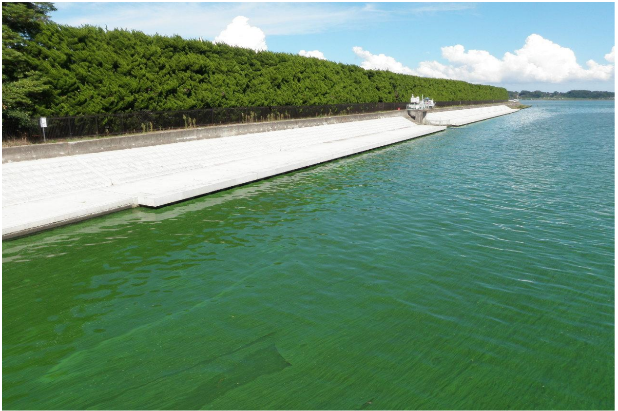
西浦中岸3.25km下 (新川) レベル3~4 悪臭無し
