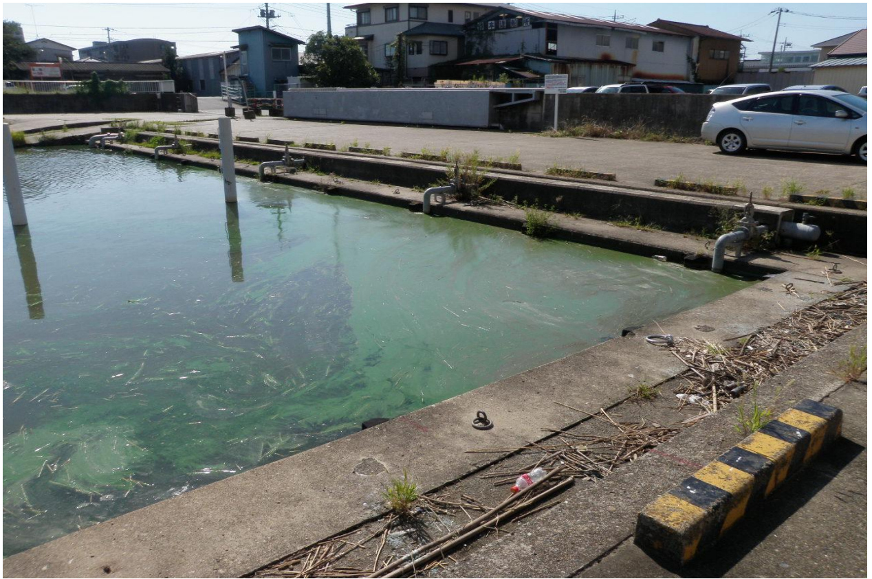
西浦中岸1.25km+200m (土浦港) レベル4 悪臭無し
