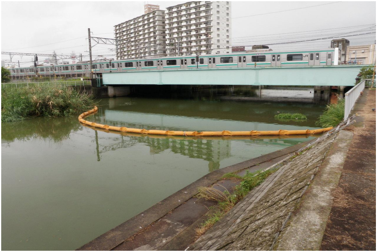
西浦中岸2.75km+40m (新川) レベル2~3 悪臭無し
