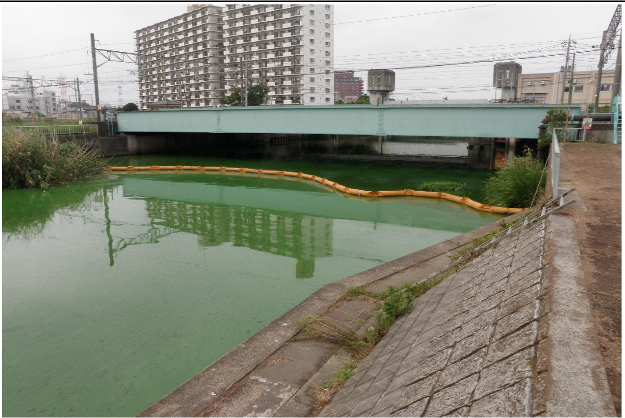
西浦中岸2.75km+40m (新川) レベル4 悪臭無し
