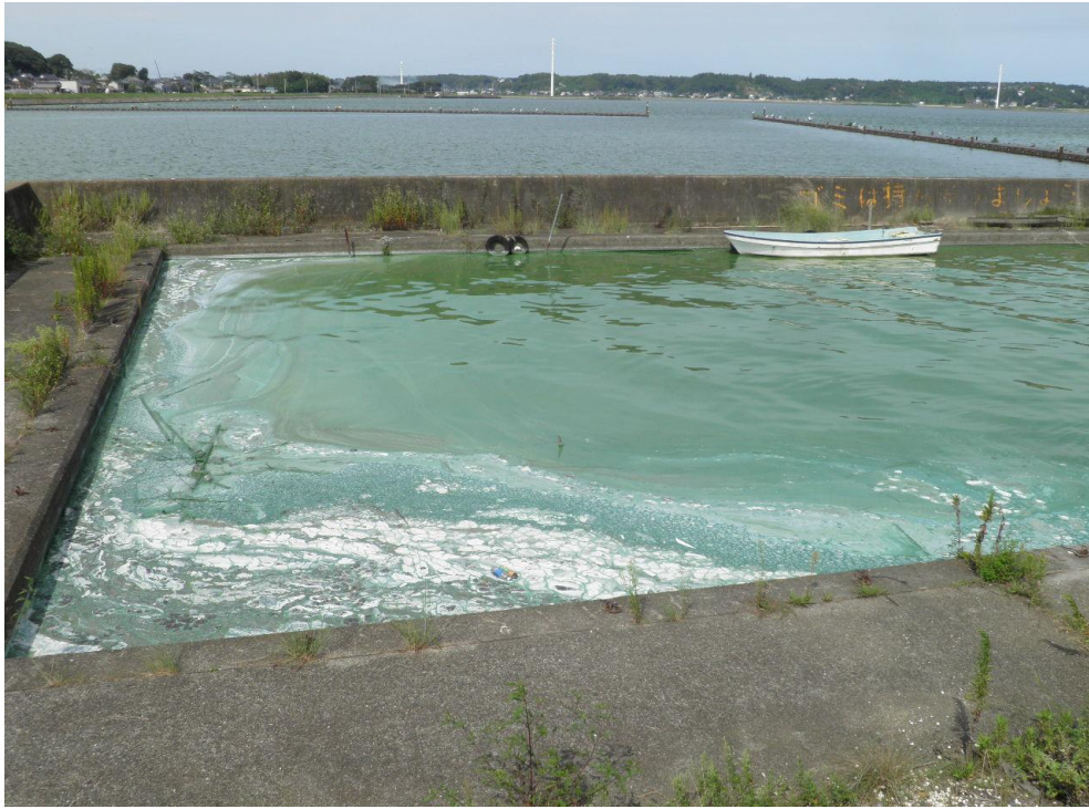
北浦右岸29.25km-40m小船津鶴ヶ居舟溜まり内 レベル: 5 悪臭: 有
