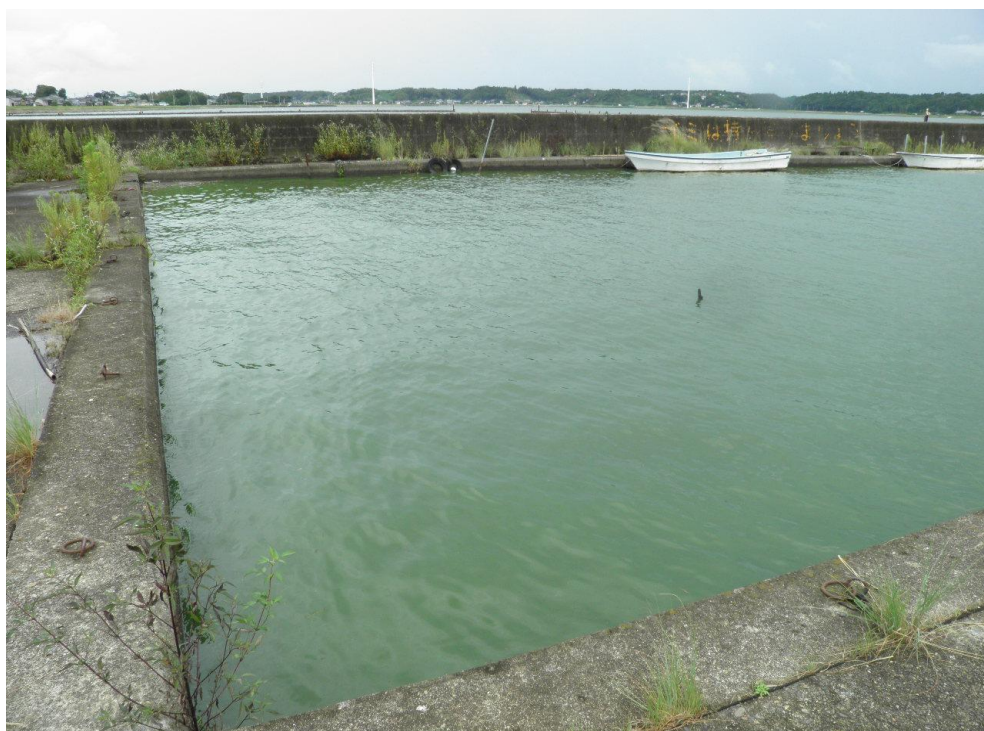
北浦右岸29.25km-60m鶴ヶ居舟溜り内
