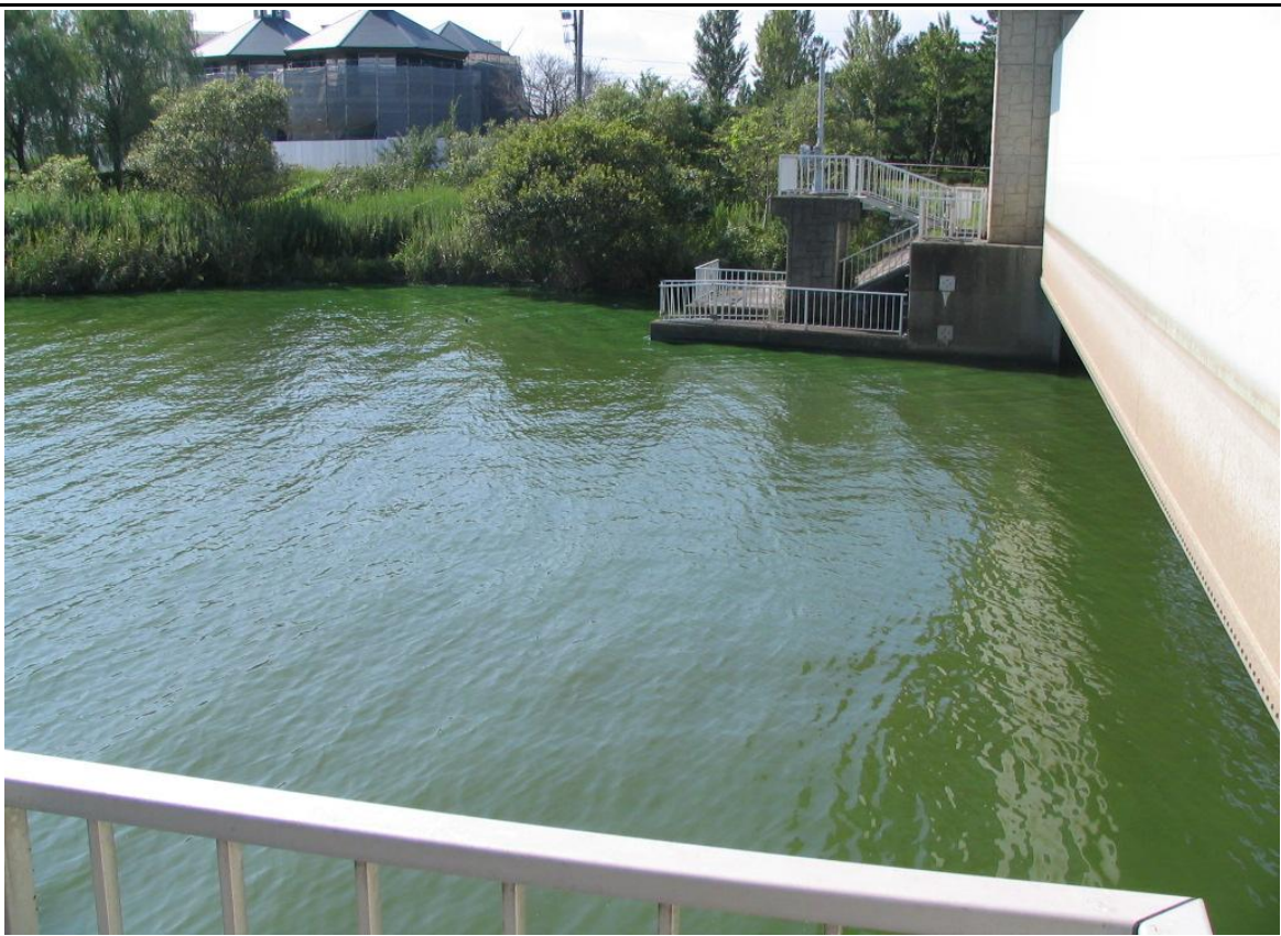
西浦右岸47.25km+50m 備前川河口 レベル3~4 悪臭無し
