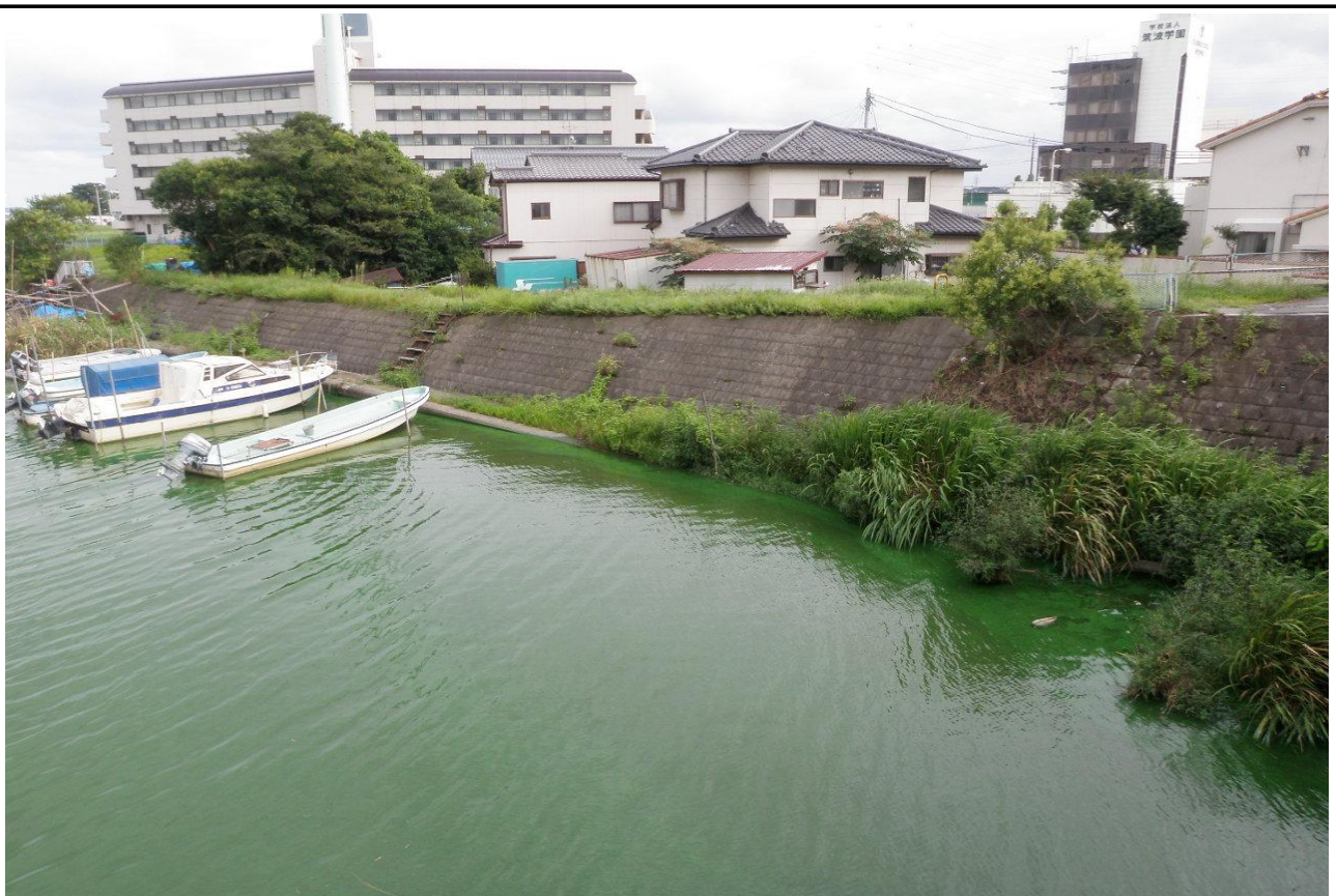
西浦中岸2.50km+100m (新川) レベル3 悪臭無し
