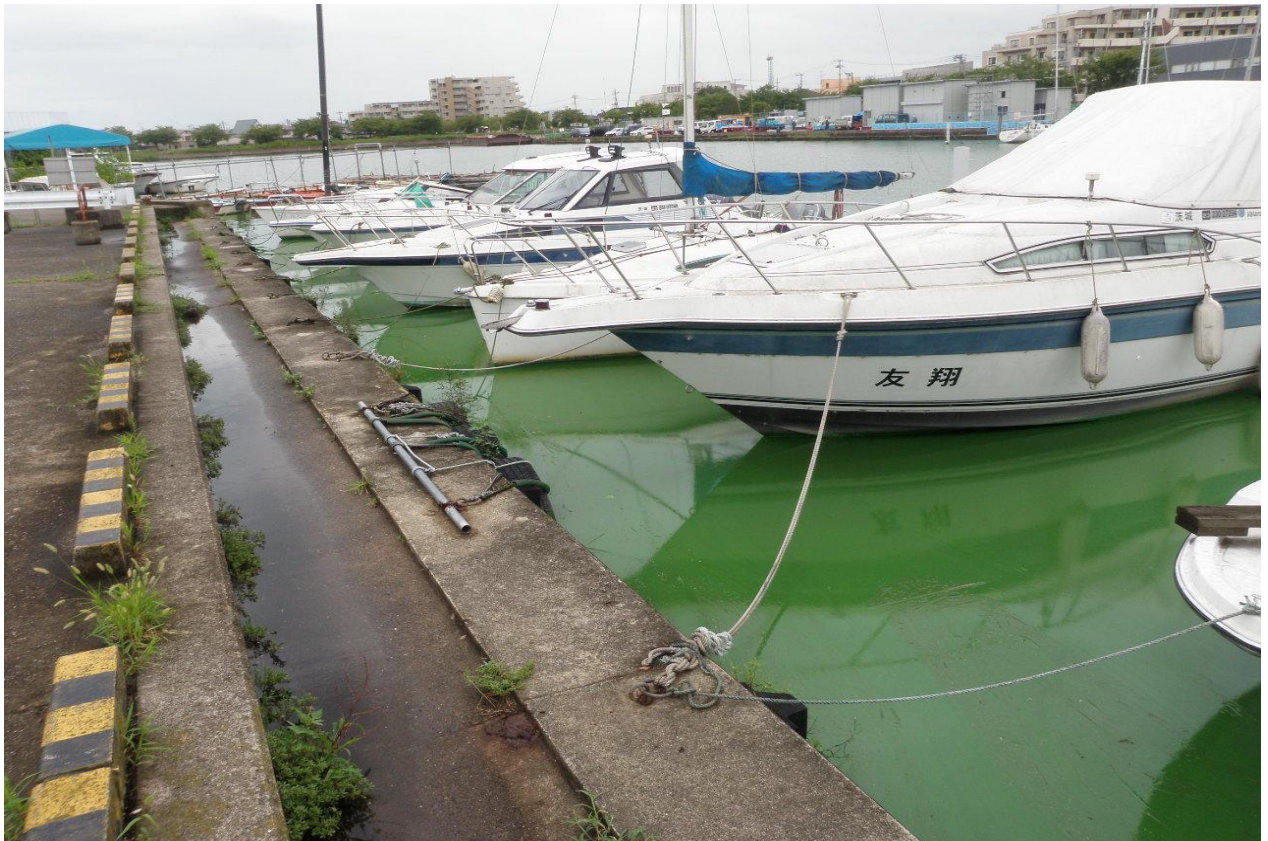
西浦中岸1.50km+50m (土浦港) レベル4 悪臭無し
