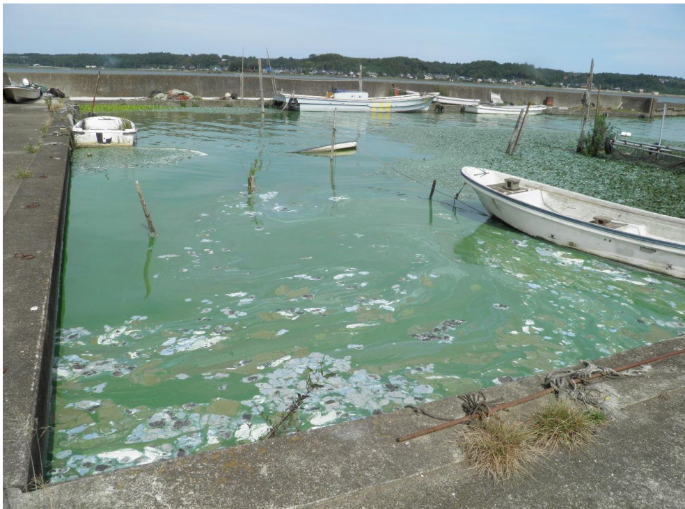
北浦右岸31.0km+80m帆津倉第一舟溜まり内
