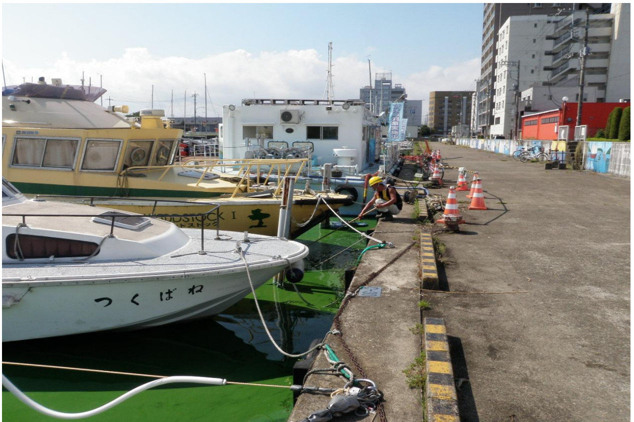
西浦中岸1.25km+300m (土浦港) レベル4 悪臭無し
