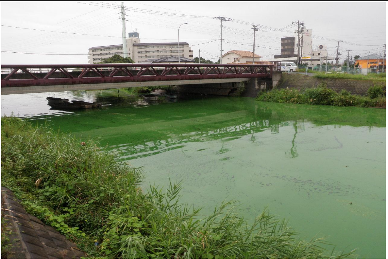
西浦中岸2.75km-100m (新川) レベル4 悪臭無し
