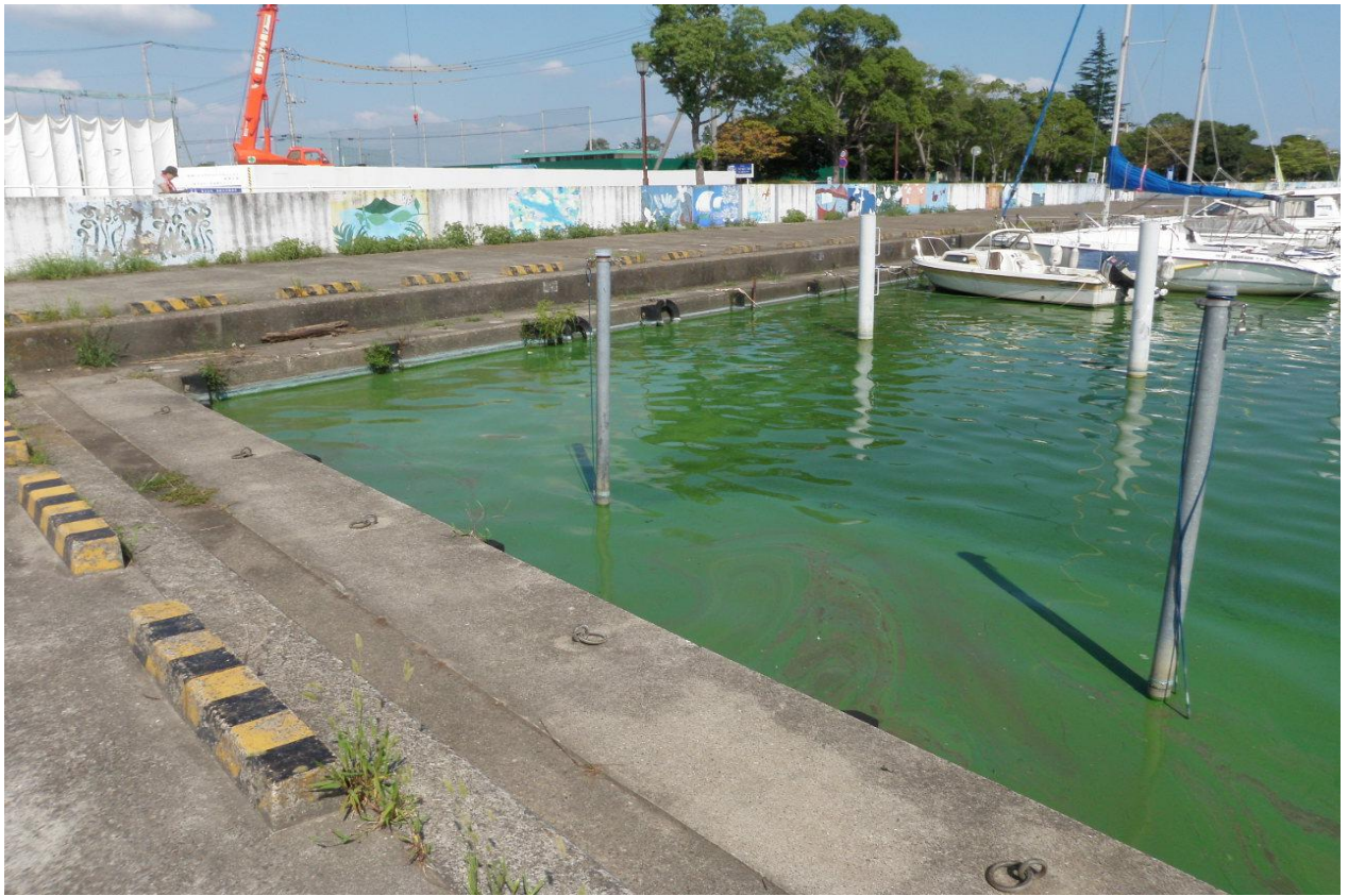
西浦中岸1.50km-100m (土浦港) レベル4 悪臭無し
