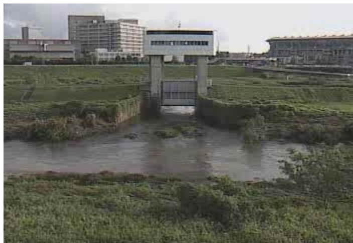
鶴見川多目的遊水地排水門からの排水状況(9月16日16時20分頃)
