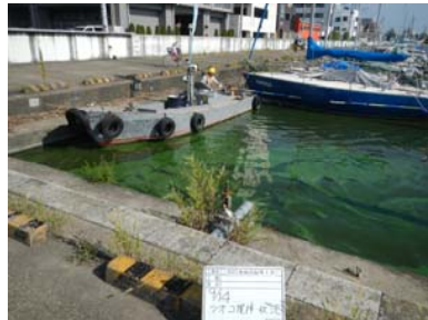
作業船によるアオコ攪拌作業①
