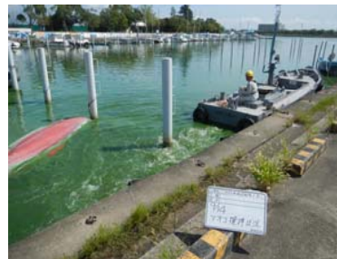
作業船によるアオコ攪拌作業②
