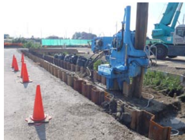
施工状況(仮設工:鋼矢板打設工)
