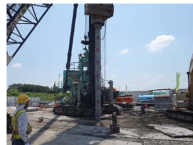
施工状況(機場本体工:基礎杭打工)
