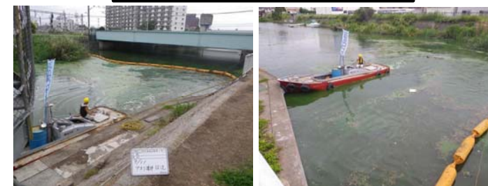
作業船によるアオコ攪拌作業③
