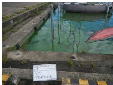
作業前アオコ発生状況②
