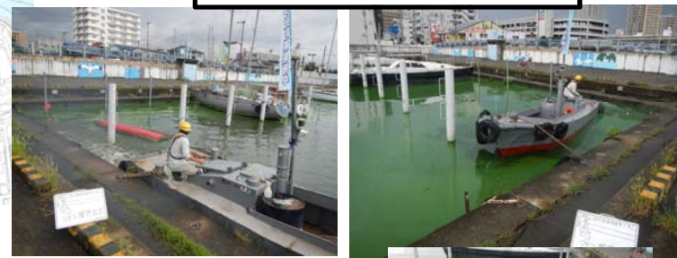
作業船によるアオコ攪拌作業②
