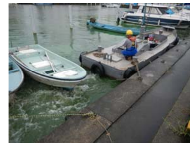
作業船によるアオコ攪拌作業③
