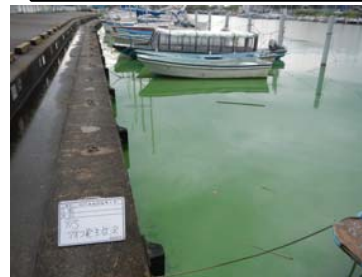
作業前アオコ発生状況③
