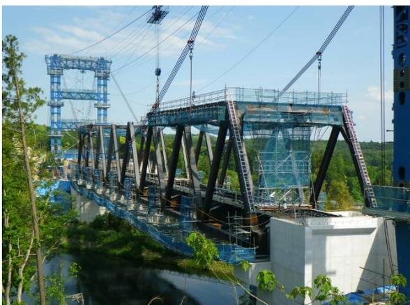
ケーブルクレーン直吊工法による架設状況
