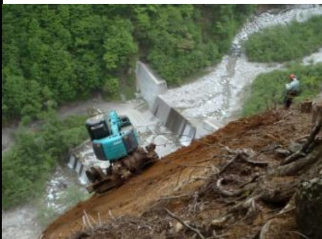
高所法面掘削機による法面整形
