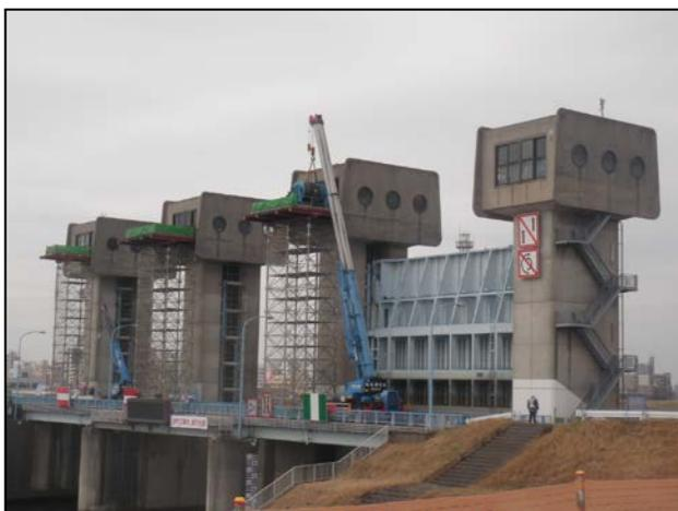
図1: 仮設構台を設置しての施工
