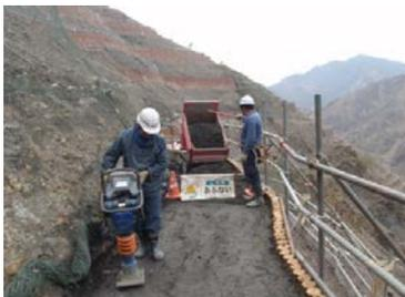
補強土壁工(埋戻工)施工状況
