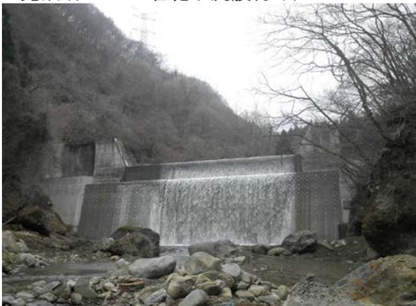
施工状況(スリット堰堤上流腹付け)
