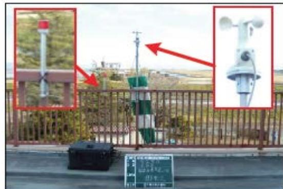
クレーン作業時の警報システム設置状況
