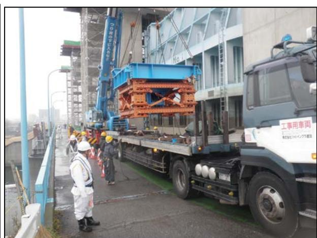
図2: 製作架台を使用しての運搬・吊り込み
