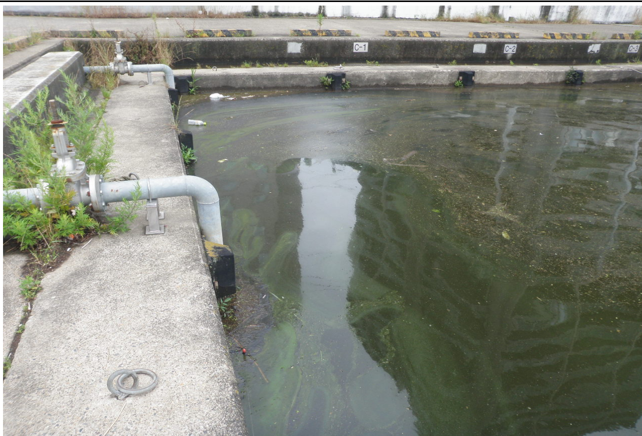
西浦中岸1.25km+200m レベル2~3 悪臭無し
