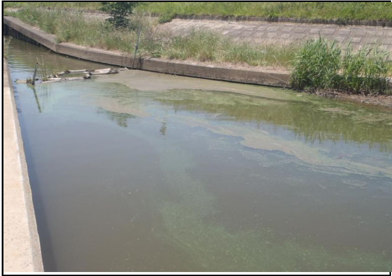
西浦中岸34.75k+200m付近 レベル3
