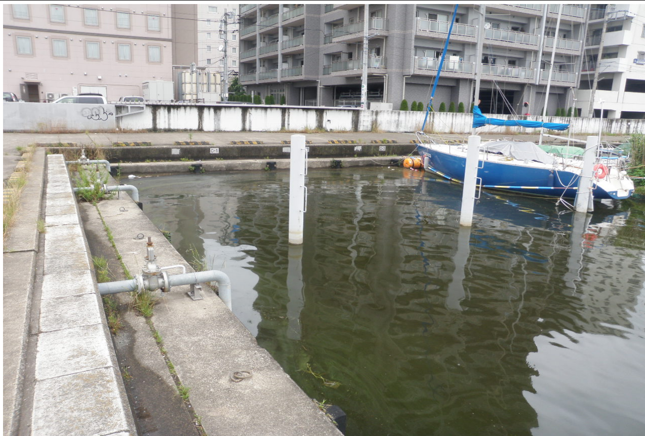
西浦中岸1.25km+200m レベル2~3 悪臭無し
