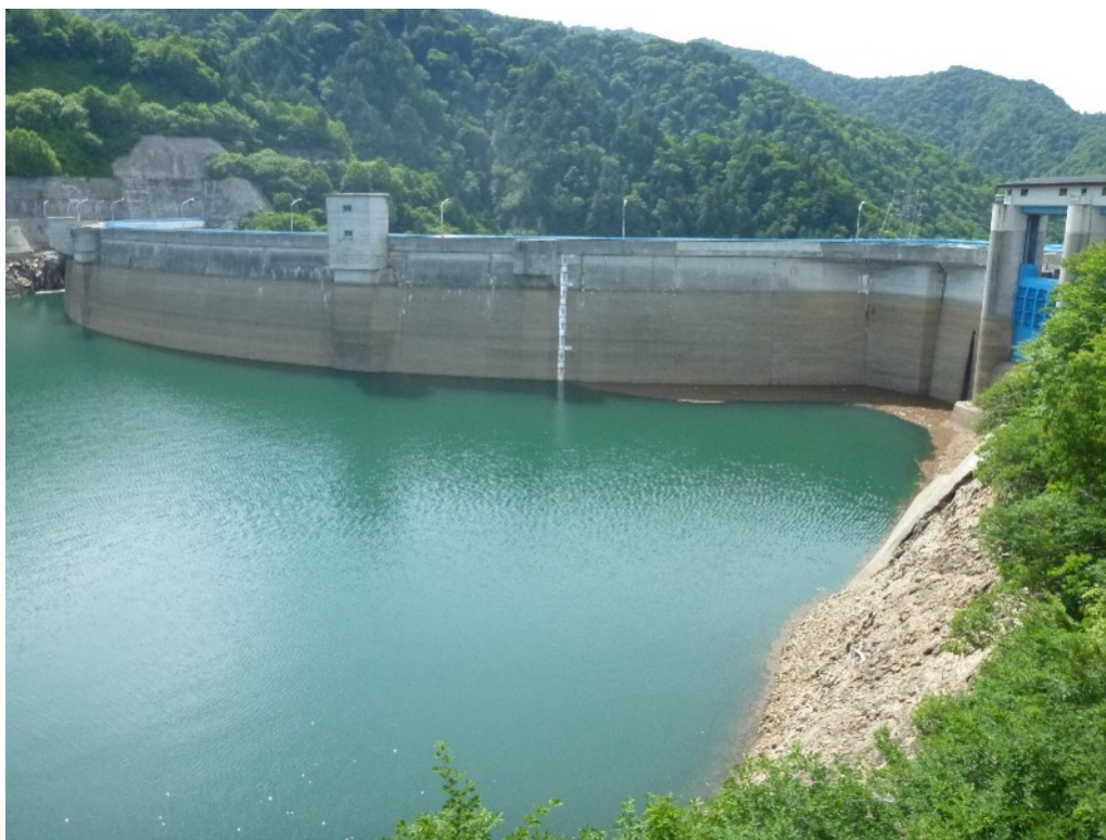
写真：矢木沢ダム (撮影日 7月16日)
