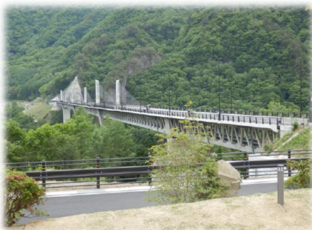
不動大橋（湖面2号橋）
