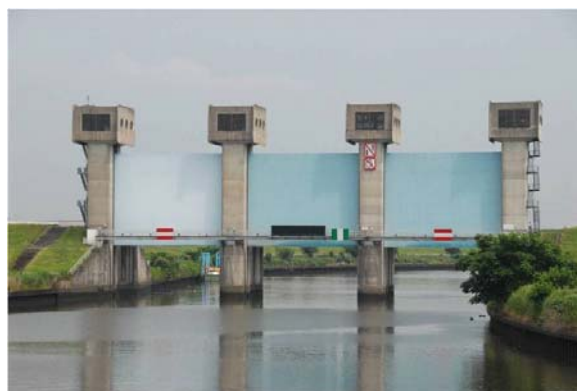
写真1. 施設の例 (岩淵水門)
