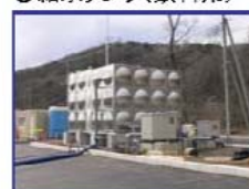
○給水タンク(飲料用)
