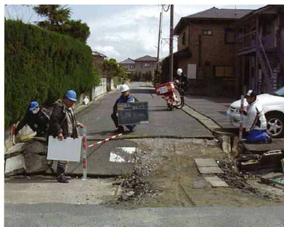
道路の被災状況の調査
