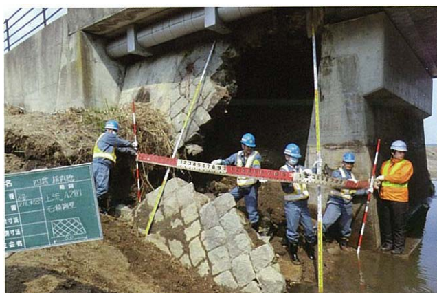
福島県いわき市・国道6号の被災調査 石積擁壁崩壊
