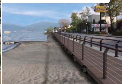
○国道に併設して湖畔に整備する箇所
