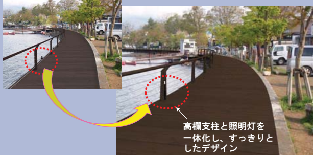
■支柱コンクリートの明度抑制(粗面仕上げ - モールドスター工法 -)
