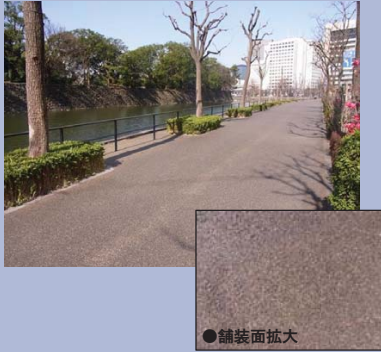
事例箇所： 皇居周辺（内堀通・竹橋付近）
