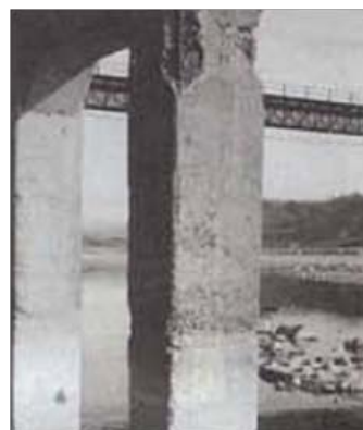
中和事業以前の河川橋脚
