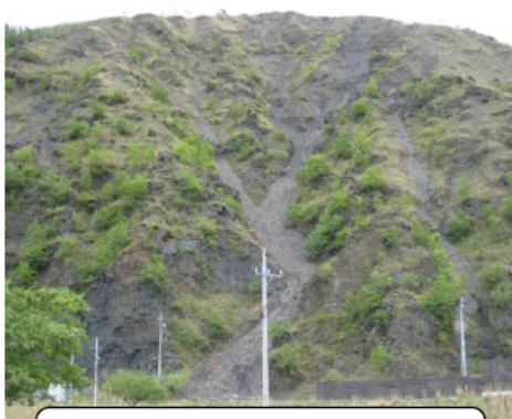
工事前の久蔵口
